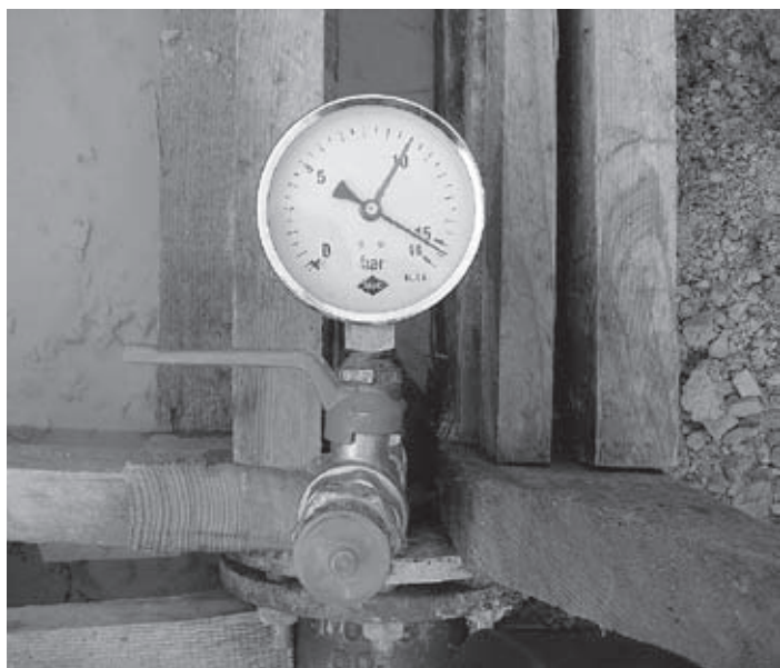
Preizkus tlaka v obnovljenem vodovodu v Zagradu; 16 barov mora zdržati 24 ur. Šele potem se zasipajo cevi.
