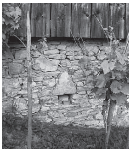
Trikotno oblikovan kamnit klesanec premošča težo nad majhno okensko odprtino.
